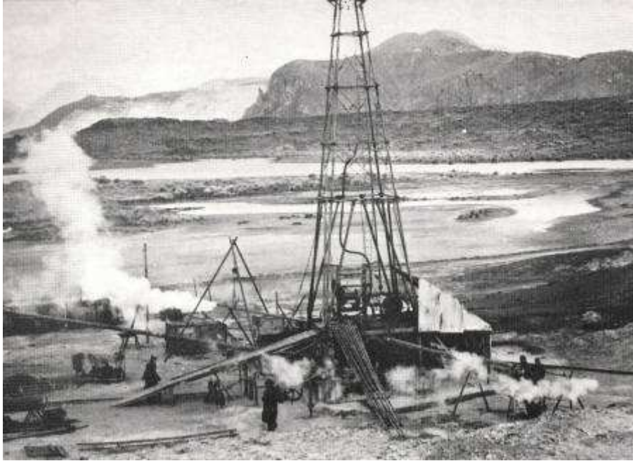
1953 Pozzo VU2bis in perforazione nell'isola di Vulcano (operatore Agip)
